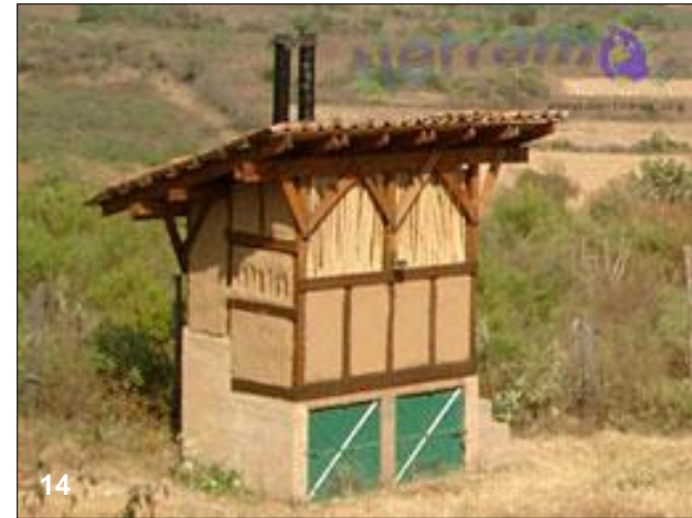
Sanitario de composta de doble cámara
