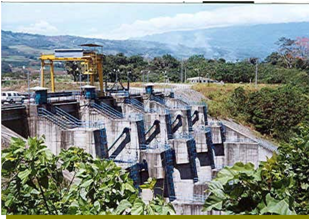
Angostura Vertedero de Excedencias
